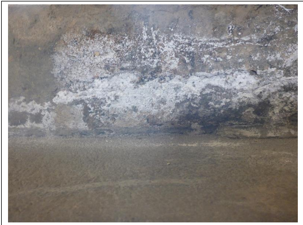
Abb. 17: Vst Leuna Werke Süd, PU km 19,287: Treppenaufgang zum Bahnsteig 2, Beton mit Salzausblühungen
