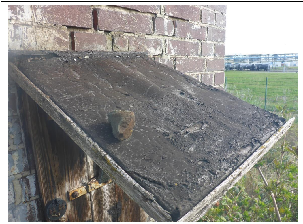
Abb. 7: Vst Leuna Werke Süd, Bahnsteig 1, km 19,200: Betriebsraum: Dachabdichtung
